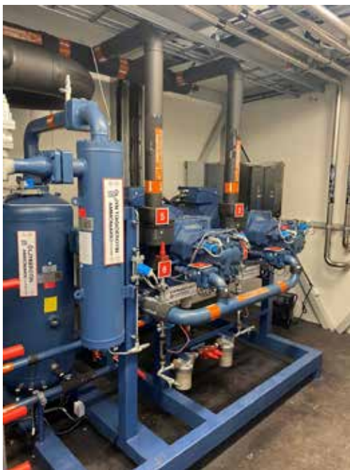
Kuva 1. Esimerkki venttiilien ja putkiston oikeista merkinnöistä (kuva: Jomcon Oy).
