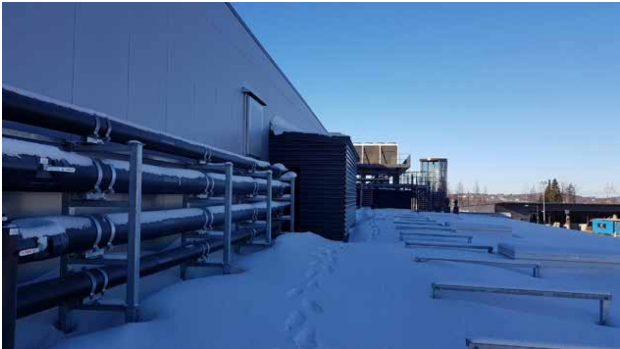
Kuva 2. Esimerkki oikeaoppisesta putken kannakoinnista; kannatus on eristeen ulkopuolella, ja putki riippuu "kannatusspannan" varassa siten, että sillä on mahdollisuus liikkua vapaasti esim. lämpölaajenemisen seurauksena. (kuva: Jomcon Oy).
