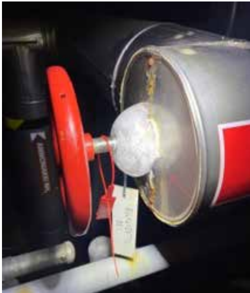
Kuva 7. Jäänyt sulkuventtiili (kuva: Jomcon Oy).
