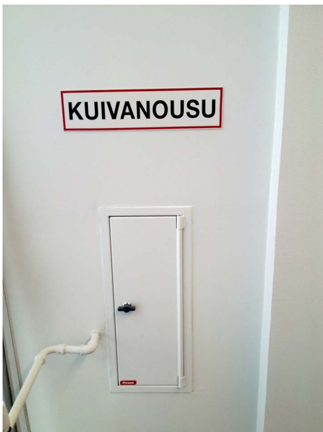
Kuva 2. Kuivanousun ulosotto kiinteistön porrashuoneessa.
